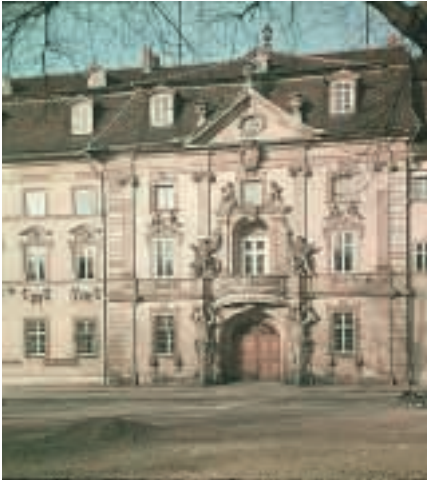
Ehemalige kurmainzische Statthaltereibibliothek, Außenansicht Fassade (Erfurt)
